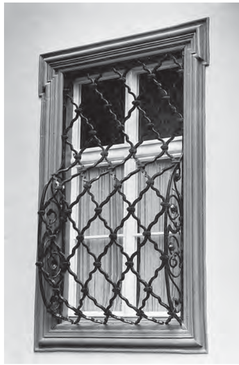
Abb. 127: Chur, Altes Gebäu. Korbgiitter aus der Bauzeit 1727-29 im Erdgeschoss der Gartenfront.
