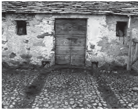
Abb. 156: Alp da Cavloc, Stallgebäude. Ansicht von Nordwesten. Eingang zu einem der fünf Stallabteile. Neben dem Tor die Luftöffnungen für die Frischluftzufuhr. Der Vorplatz ist mit Rundbollensteinen gepflästert, die zwei Kanäle dienen zur Stallentmistung.
