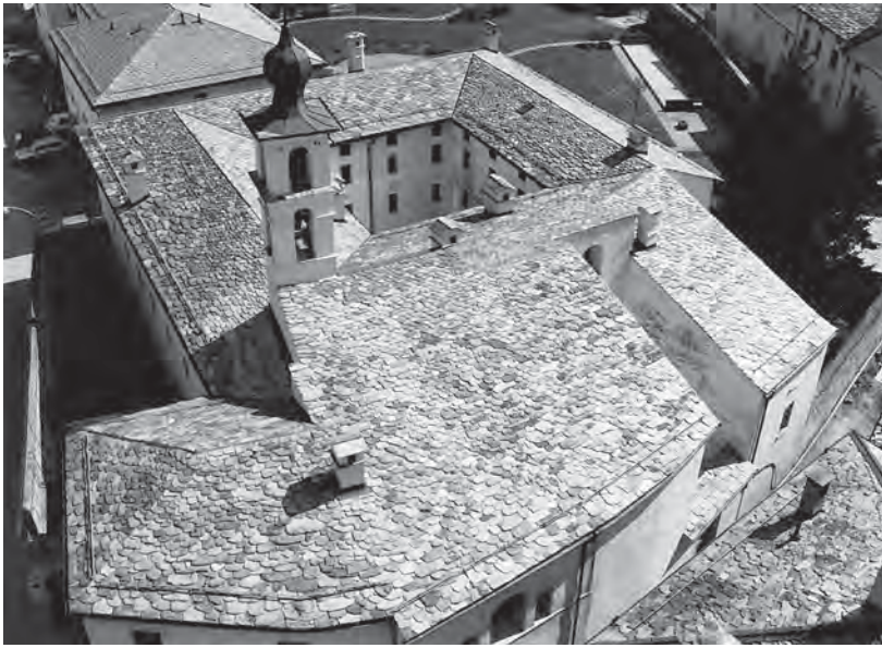
Abb. 88: Blick vom Campanile der Kirche San Vittore auf die Dachlandschaft des alten Frauenklosters in Poschiavo. Ansicht von Westen.
