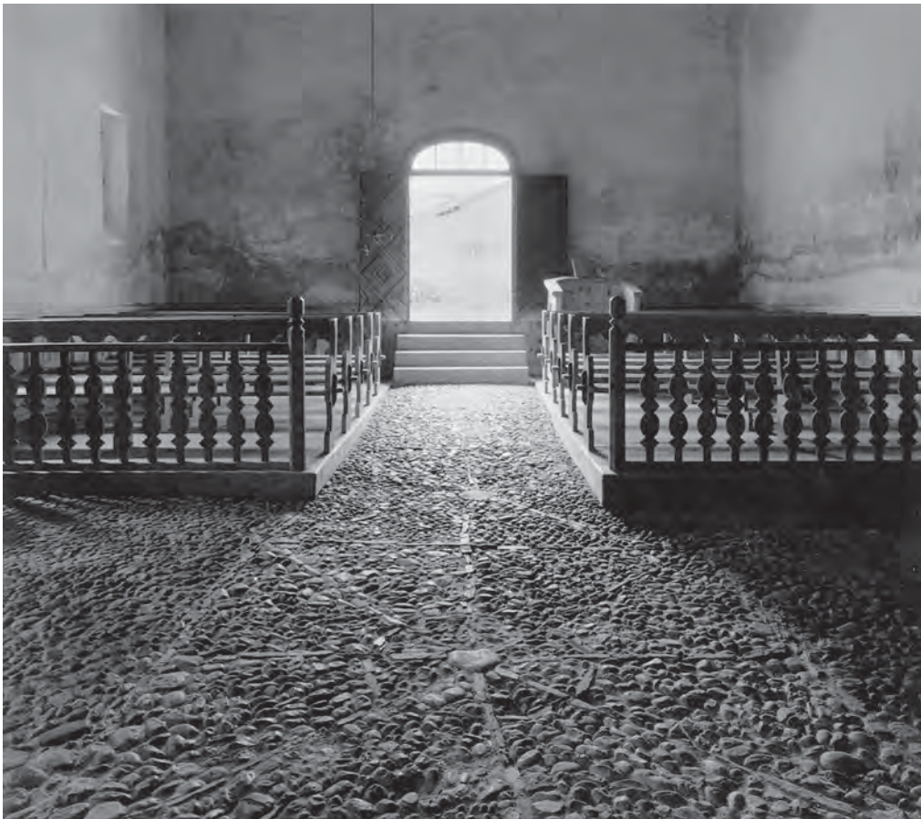
Abb. 120: Evangelische Filialkirche Garsun. Bollensteinpflasterung mit sternförmigem Muster im Gehbereich des Schiffes. Ansicht von Osten.
