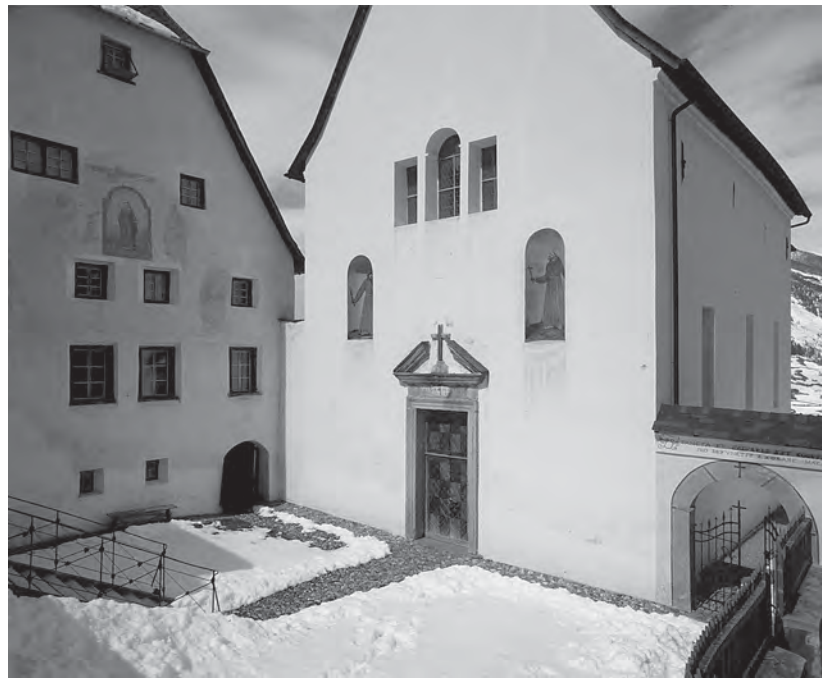
Abb. 169: Der Kirchenvorplatz in Mon ist ganz auf die Eingangsfassade der Pfarrkirche, eines barocken Baus des Misoxers Giulio Rigaja von 1648, ausgerichtet. Vor wenigen Jahren wurde das aus derselben Epoche stammende Pfarrhaus an der Nordseite restauriert und die Pflasterung instand gesetzt.
