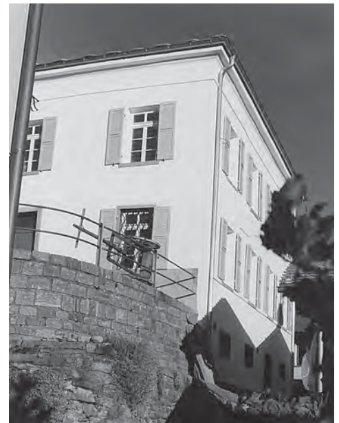
Abb. 137: Sta. Maria, altes Schulhaus. Südwestan- sicht.
