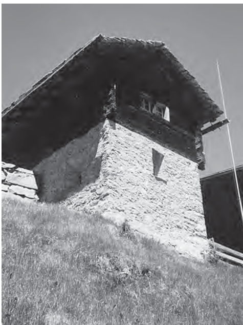
Abb. 134: Patzen, "La Caplutta". Südostansicht.
