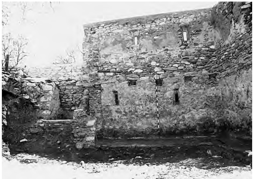
Abb. 73: Rodels, Parzelle 275. Gebäuderest nach Abtrag der Auffüllschichten. Ansicht von Norden.
