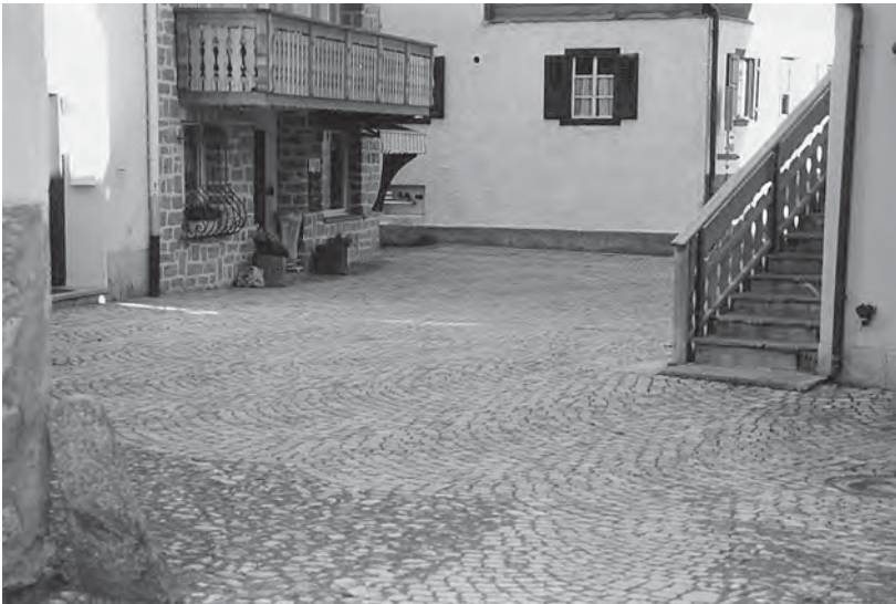
Abb. 174: Die Abbildung illustriert zwei Aspekte: einerseits, in welchem Masse die Minimallösung ›Oberflächen‹ von der Behandlung der Randbebauung des Platzes abhängig ist; andererseits, wie wichtig der Einbezug der angrenzenden Strassenräume ins Konzept ist. Im Falle dieser Neugestaltung eines Platzes in Bivio wurde der Übergang zur bestehenden Pflasterung über die Bogen der neuen Steine hergestellt. In einem kleinen Streifen führt die Würfelpflasterung weiter in die angrenzende Gasse.
