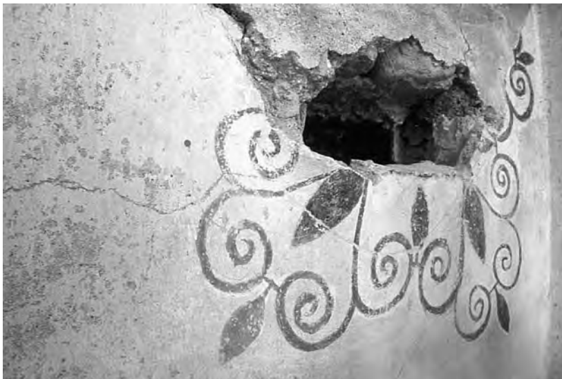
Abb. 3: Müstair, Kloster St. Johann. Niklauskapelle, südliche Ostfassade des Kapellenschiffs: Die romanische Fensterbrüstung wurde 1626 mit Dekorationsmalereien verziert, 1648 aber bereits zugemauert.
