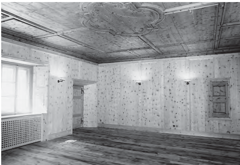
Abb. 100: Poschiavo, altes Frauenkloster. Das ehemalige Refektorium mit originaler Decke und neuem Wandtäfer aus Arvenholz (Raum Nr. 8).
