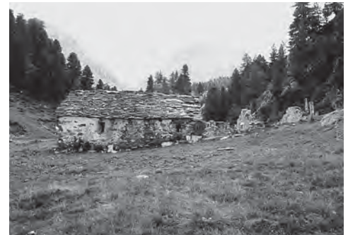
Abb. 153: Alp da Cavloc, Alte Sennerei. Nordansicht. Von den bergseitigen Käsekellern sind nur noch die Mauern vorhanden.
