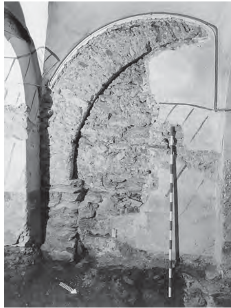
Abb. 92: Poschiavo, altes Frauenkloster. Zugemauerter Arkadenbogen in der Westwand der heutigen Eingangshalle.
