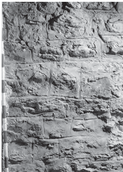
Abb. 91: Poschiavo, altes Frauenkloster. "Pietra rasa"- Verputz mit Fugenstrich an den Innenwänden des spät- mittelalterlichen Wohn- turmes.
